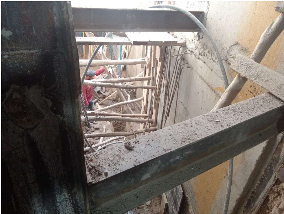
Figure 12 : Mise en place de butons horizontaux
