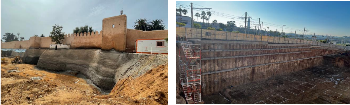
Figure 11 : photos en phase travaux du parking Bab Fès
