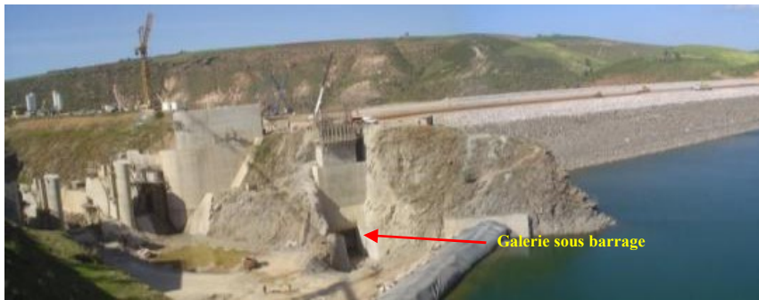
Figure 5. Barrage SMBA en surélévation – Démolition EVC et creusement galerie à l'explosif
