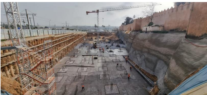
Figure 10 : photo de la fouille du projet Parking Bab Fès à Salé
