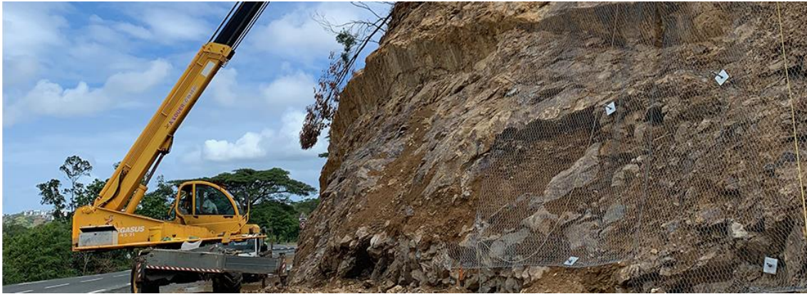
Figure 7. Talus routier rocheux cloué (Clous associés à un grillage), (www.moducal.nc).
