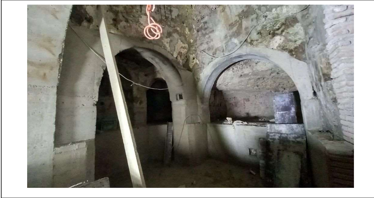
Figure 15 : Confortement et transformation des caves voutées
