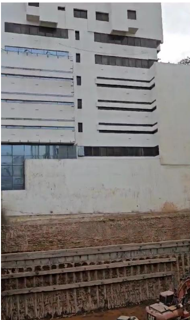
Figure 3 : photo de la fouille du projet M'OFFICE à Casablanca
