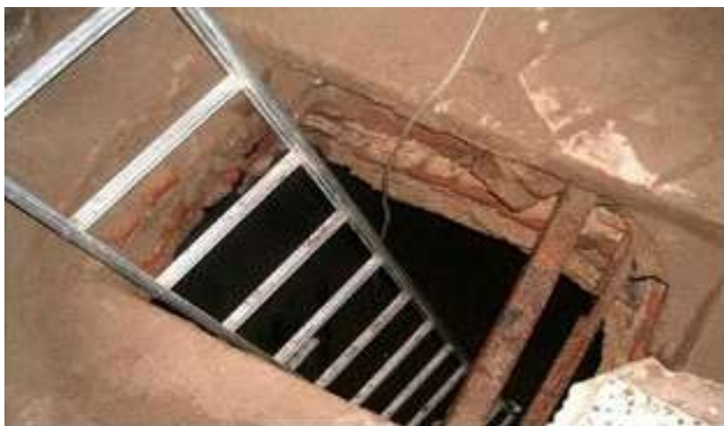
Figure 1: Accès vers les caves
