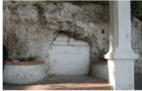
Figure 7 : Sous cavages sur falaise calcaire obturés
