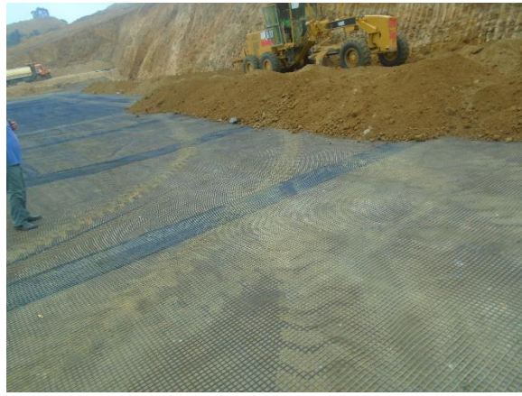
Figure 2. Vues d'un remblai renforcé par géogrilles sur versant en cours de construction
