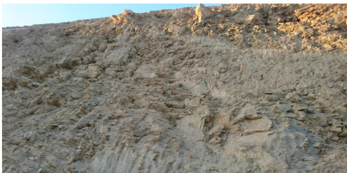
Photo 1. Vue des terrains marno-schisteux du déblai D7
