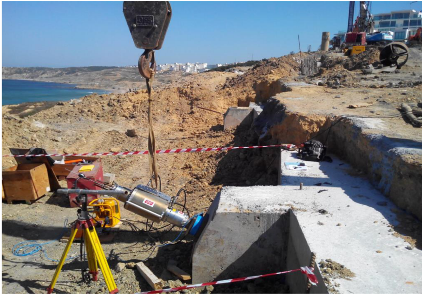
Figure 7: Mise en tension d'un tirants d'ancrage
