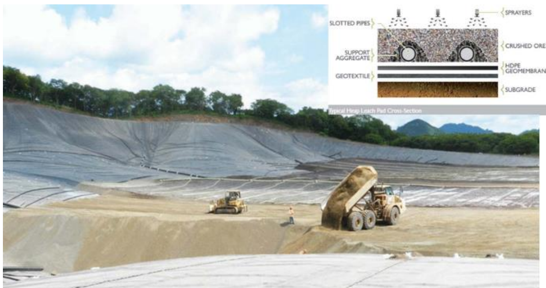
Figure 2. Exemple d'un site minier, lixiviation en tas.
