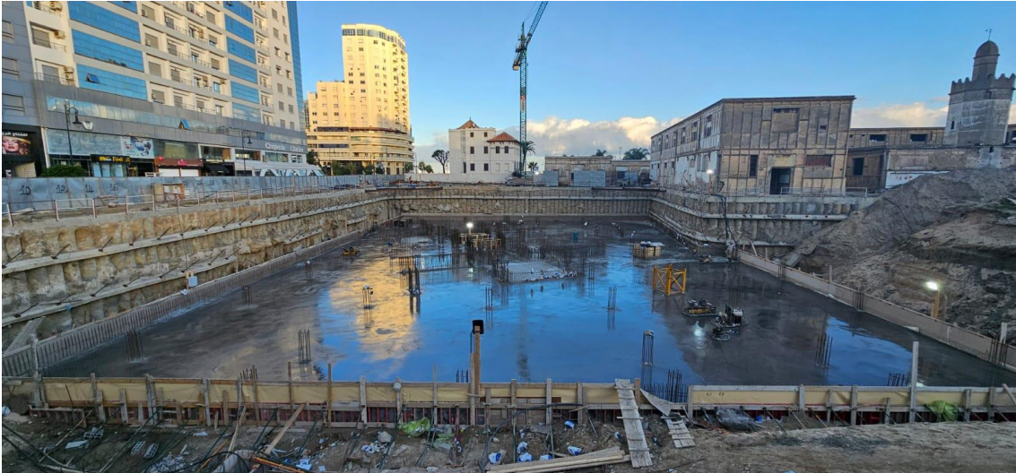
Figure 15 : photo de la fouille de la tour T1
