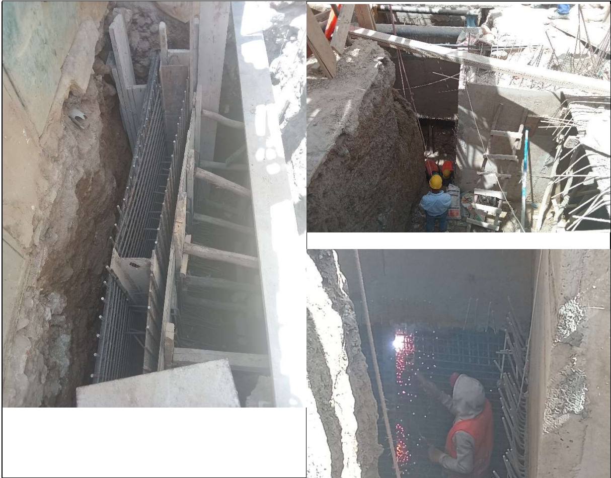
Figure 11 : Réalisation du blindage
