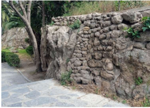
Figure 7 : Sous cavages sur falaise calcaire obturés
