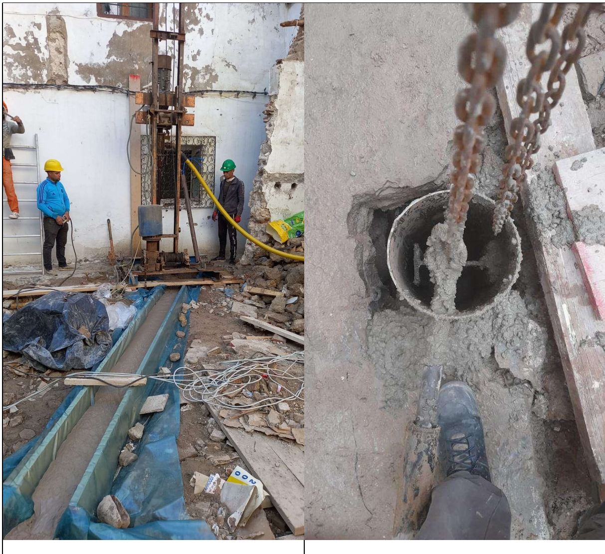
Figure 10 : Forage des Pieux
