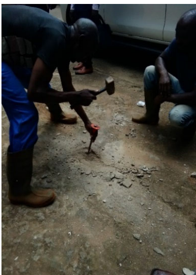
Figure 8 : Exécution des sondages par puits manuels
